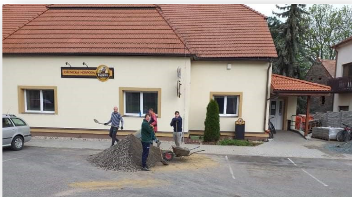
Výstavba pergoly Dřenickej hospody (jaro 2020)
